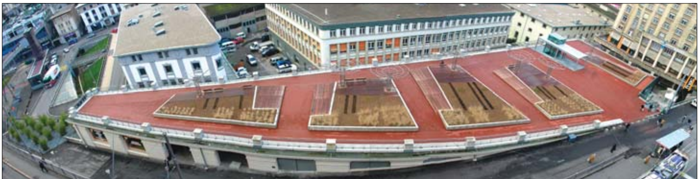
Photo panoramique toiture: Hüster sàrl
