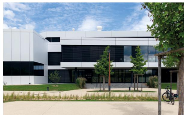
Cette structure porteuse est traitée avec des poteaux-traverses métalliques et d'un habillage en Alucobond. L'ensemble du bâtiment propose des triples vitrages et des stores brise soleil orientables. Pour les parties administratives des premiers et deuxièmes étages, on retrouve des faux-planchers au sol et des faux-plafonds métalliques. Les surfaces locatives du rez-de-chaussée et des espaces industriels sont quant à eux livrés avec une finition brute.
