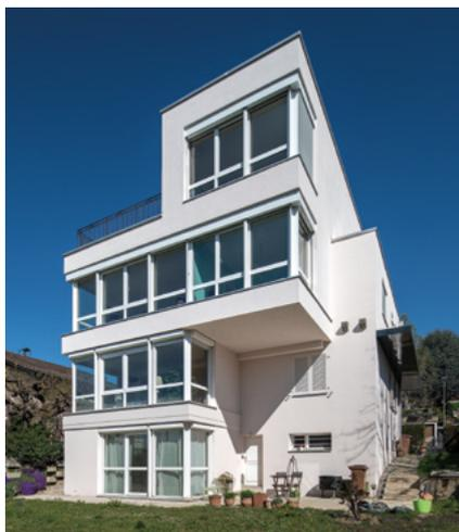
en structure bois. La balustrade à l'attique est un barreaudage assurant un maximum de visibilité. La pergola, en structure métallique, posée sur la terrasse à l'attique apporte en été de la fraîcheur aux espaces intérieurs. Les façades sont en isolation périphérique crépie et les vitrages en PVC blanc. Une partie de la surface de la toiture plate est en panneaux solaires photovoltaïques, et la ferblanterie en Uginox.
