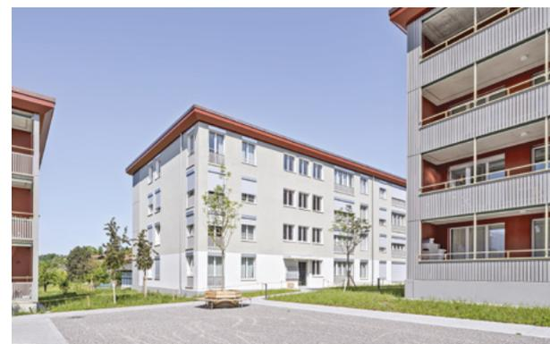
Die Überbauung wurde in Massivbauweise erstellt. Die vier Gebäude stehen auf einem Untergeschoss, während sich dazwischen eine Tiefgarage für 73 Abstellplätze erstreckt. Die Fassade besteht aus einer Kompaktfassade nach Minergie P-Standard mit einem robusten mineralischen Putz. Die Balkonschichten werden mit einer Holzschalung akzentuiert und erinnern an die Lauben der Umgebung.
