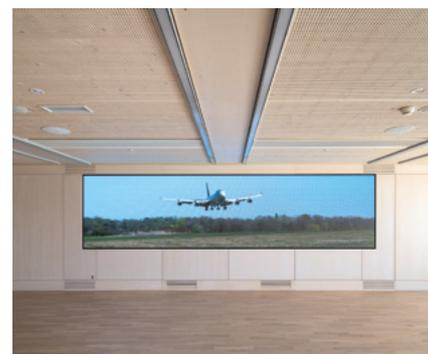
À l'intérieur, la zone de sûreté hérite d'un sol en marbre préfabriqué (MAB), de faux plafonds constitués de lamelles métalliques et d'un revêtement mural en tôles métalliques. Pour la salle de projection, les concepteurs ont opté pour un sol parquet en bois massif, de faux plafond en plaques de bois perforées et un revêtement mural composé de panneaux de bois.
