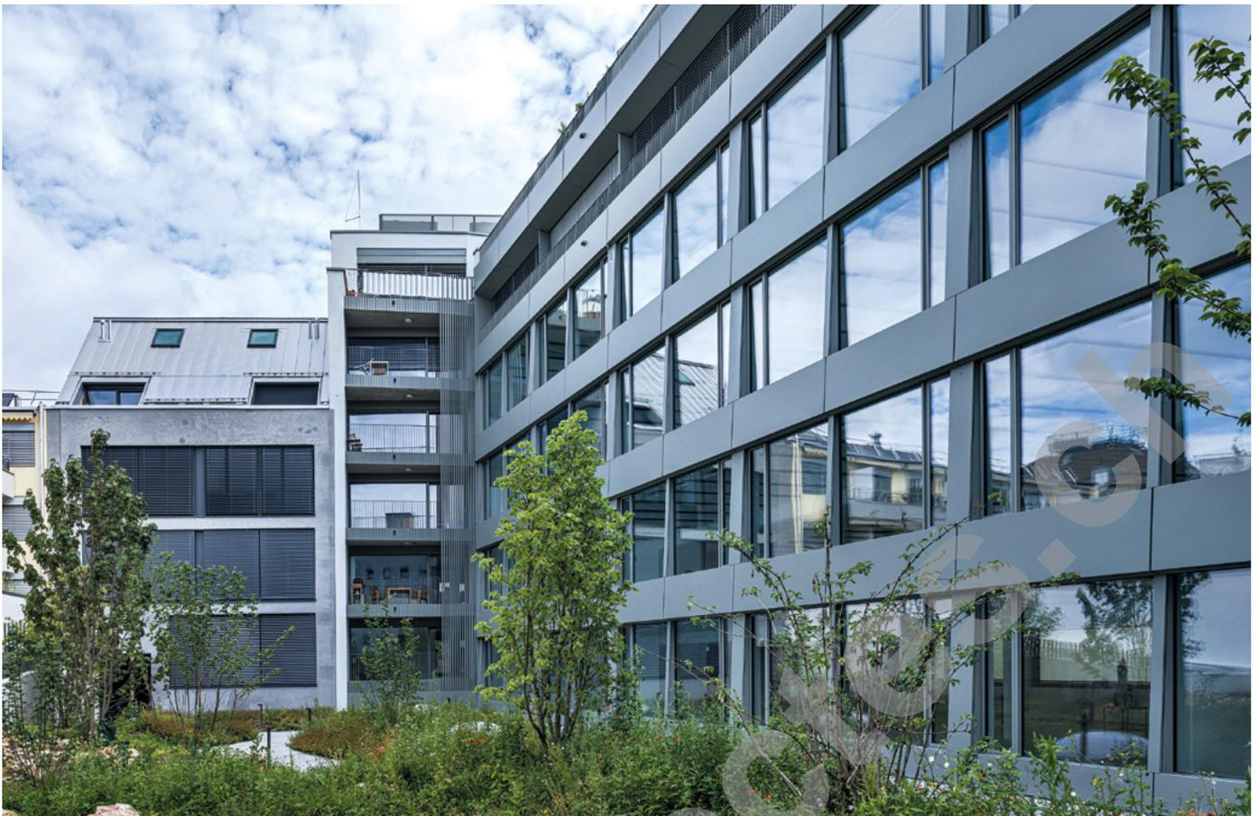
ein grüner Rückzugsort, geschmückt mit Laubbäumen. Das bestehende Gebäude an der Ecke Steinengraben/Leonhardsstrasse wurde bis auf den Rohbau entkernt und mit dem neuen Gebäudeteil am Steinengraben zu einem Baukörper verbunden. Um die Erdbebensicherheit zu gewährleisten, wurden die Brandwände des Eckgebäudes durch Stahlbetonwände ersetzt. Innerhalb des Eckgebäudes entstanden neue Steigzonen für eine zeitgemässe Lüftung und Haustechnik.
