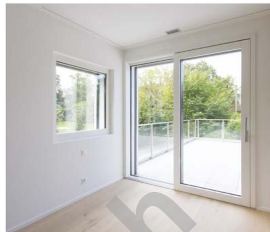
**TECHNIQUE** > La construction respecte la norme genevoise THPE (très haute performance énergétique) qui réunit un ensemble de prescriptions énergétiques en matière d'exécution dans le domaine du bâtiment. Isolation périphérique, triples vitrages, solaire passif grâce aux larges ouvrants en font partie. De même que la production d'eau chaude sanitaire qui est assurée par des panneaux thermiques en toiture alors que le chauffage dépend d'une pompe à chaleur alimentée par sondes géothermiques.
