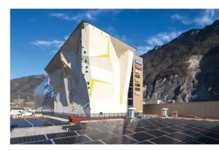
**RÉALISATION** > Le radier a dû faire l'objet d'une reprise intégrale pour le consolider par des micropieux forés sans démolition de la partie basse du bâtiment. Une structure métallique avec des pièces allant jusqu'à 24 mètres de haut a été mise en place. Enfin, une enveloppe de panneaux sandwiches a permis la réalisation dans des délais extrêmement serrés. À l'intérieur, des dalles mixtes ont été posées, laissant la finition des sols au choix des locataires des surfaces commerciales.
