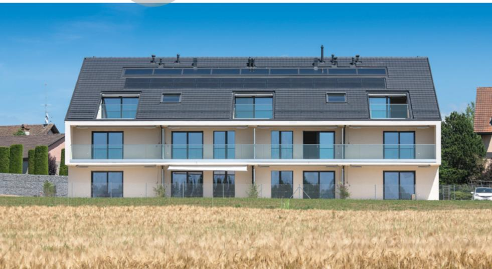
couverture en tuiles en terre cuite noire. Les balcons sont équipés d'un revêtement de sol en dalles ciment et les garde-corps sont en verre sécurisé transparent.
