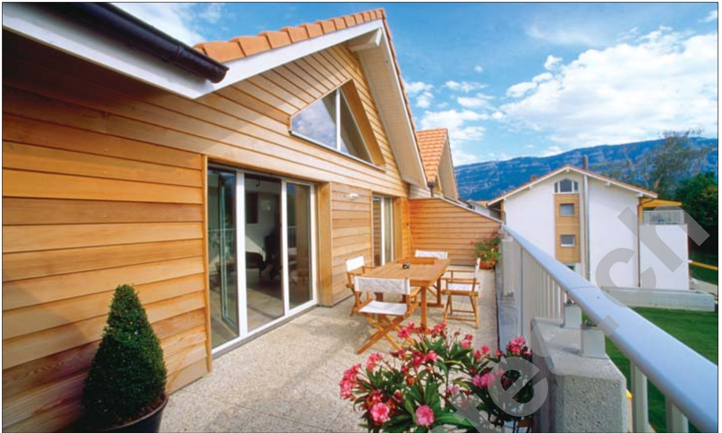
Vue sur une terrasse d'attique du bâtiment D
