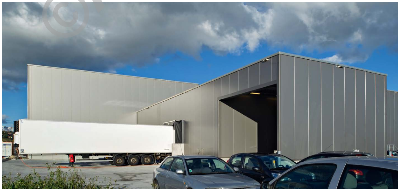
Nouveau quai et halle logistique
