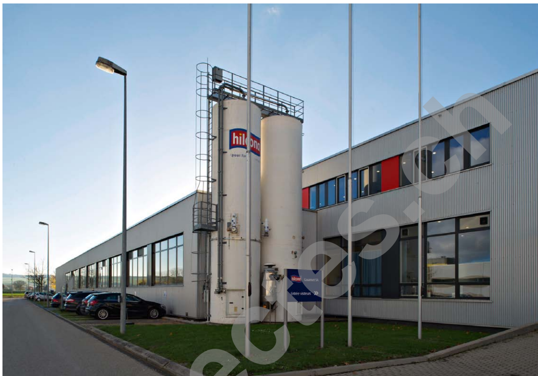
Façade bâtiment existant
