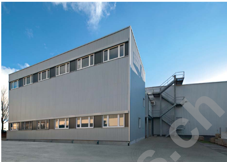
Nouveau module: bureaux et vestiaires
