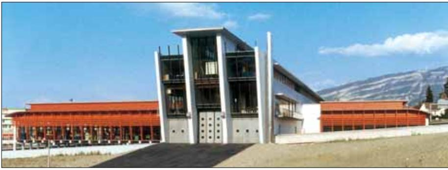
La charpente des ateliers est construite en bois lamellé-collé pour des raisons de sécurité au feu. Ce matériau s'adapte facilement aux modifications techniques et amortit les vibrations résultant des installations techniques.
