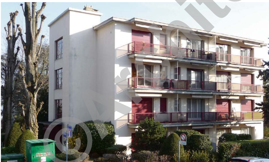
Photo avant travaux
