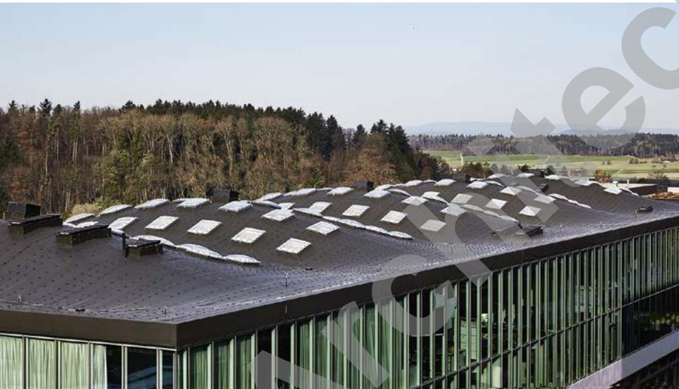
Les porteurs sont constitués de 23 couches dans lesquelles les lattes positionnées en «ceinture» ou en diagonale sont stratifiées en alternance. Un unique robot portique a suffi à l'entière réalisation de la toiture.
