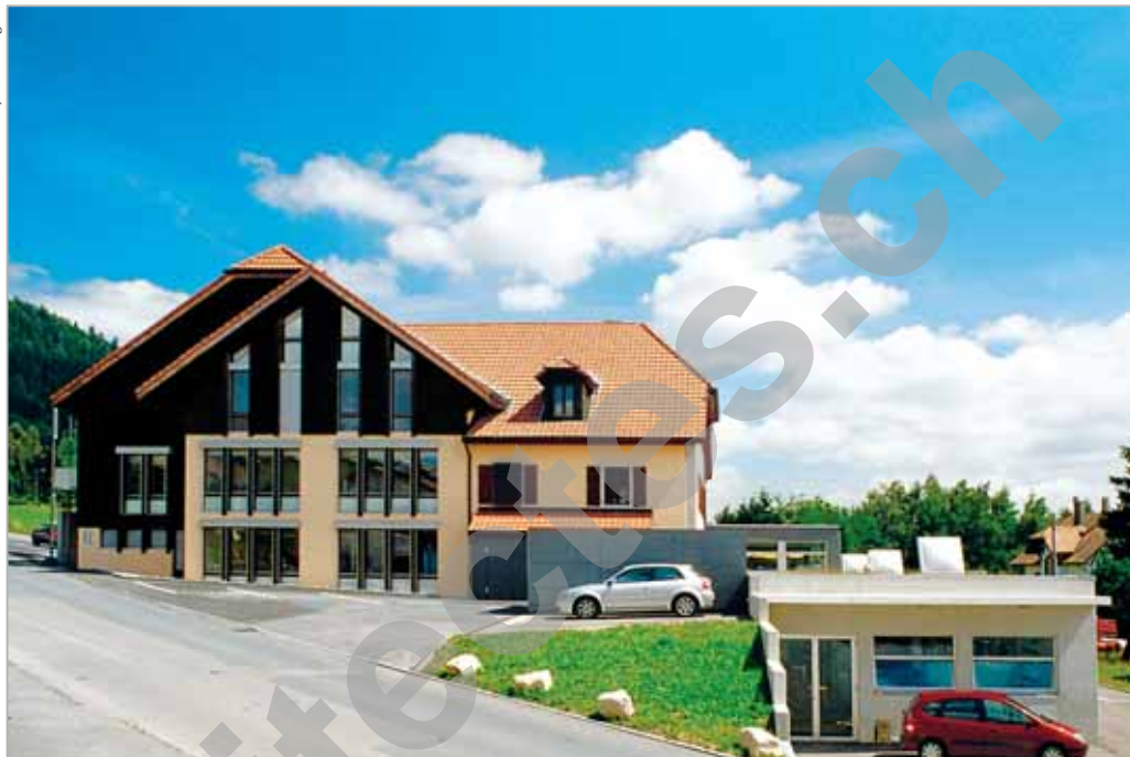
Vue d'ensemble de la fabrique, côté accès principal
