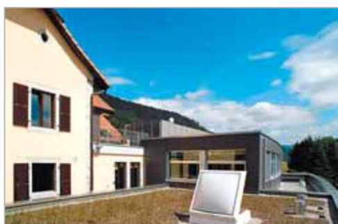
... et aérés en toiture
