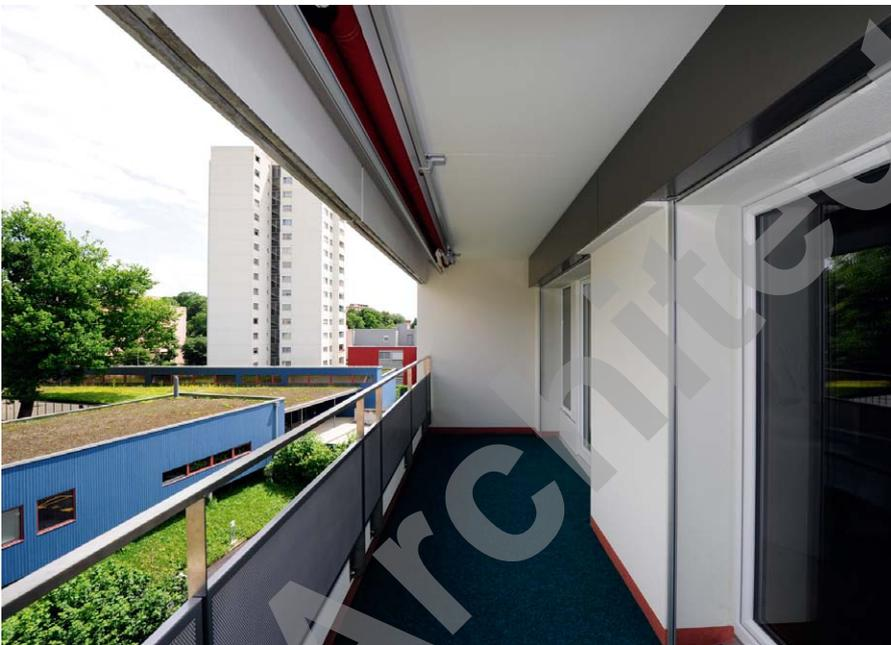
les performances d'isolation thermique déterminées par le programme d'intervention. L'ensemble dégage ainsi une impression de légèreté, marquée par le socle, constituant les garages, légèrement en retrait. Les façades sont revêtues d'une nouvelle isolation périphérique recouverte d'un crépi.
