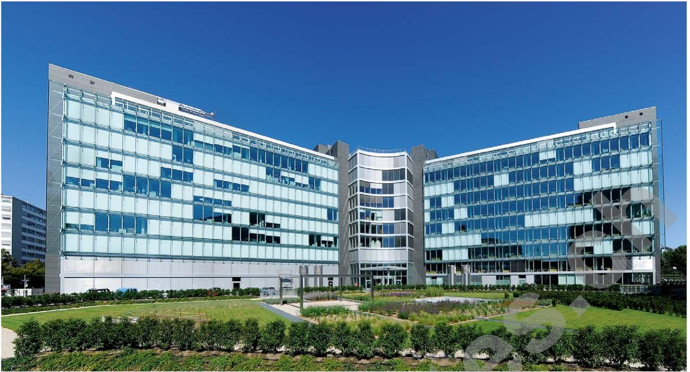
Le bâtiment central (H), ovale, fait office de liaison entre les bâtiments et de circulations verticales. Ce dernier est formé de trois niveaux de sous-sol, un rez inférieur, un rez-de-chaussée et onze niveaux. Huit ascenseurs desservent les étages. Les parties en sous-sol abritent deux niveaux de parking, reliés directement aux autres parkings existants.
