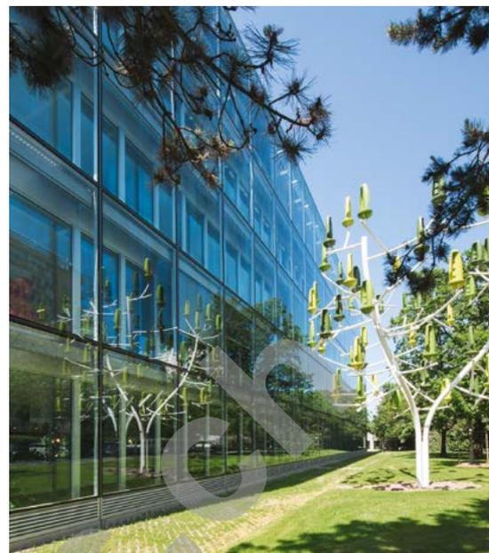
À l'extérieur, l'enveloppe de verre escamote visuellement tous les éléments porteurs et ne laisse apparaître qu'une membrane transparente, tout à la fois légère, aérienne et structurée. Cette perception est due à la juxtaposition rythmée de grands cadres vitrés qui, serrés dans un élégant châssis métallique, forment une double peau cristalline superposée à la « sous-façade » intérieure.
