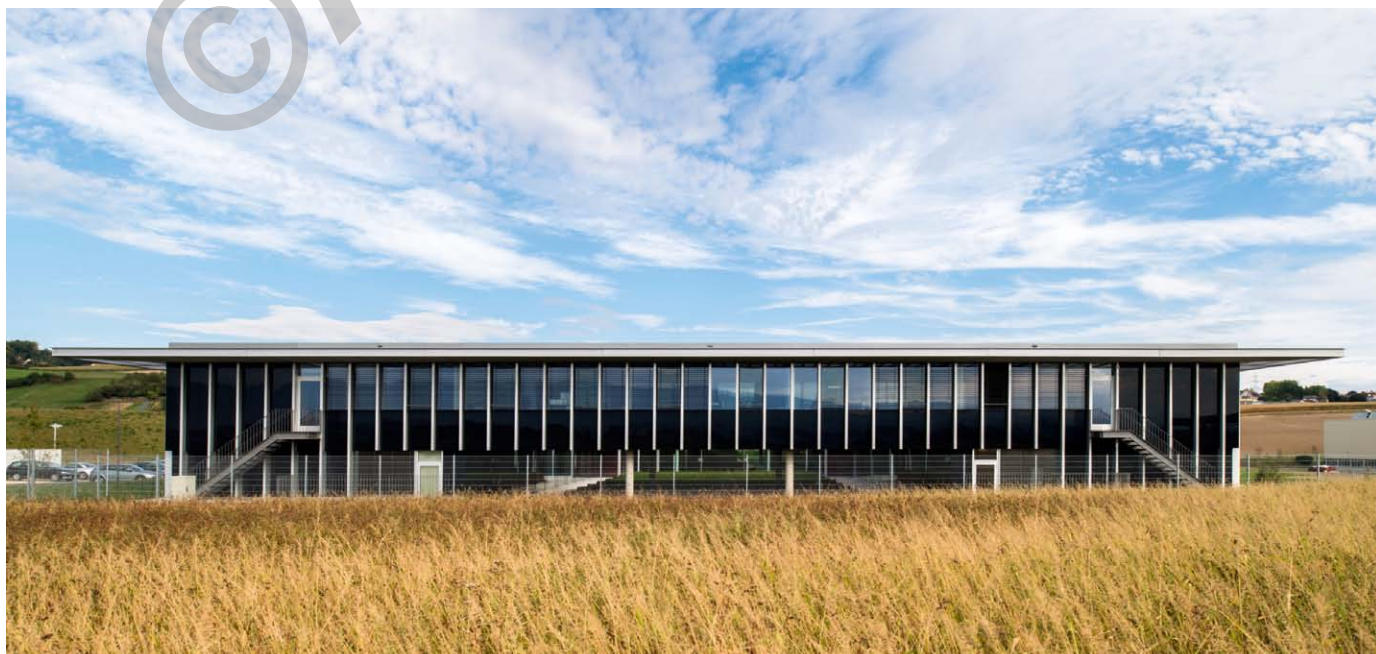
Bobst Group - Façade ouest
