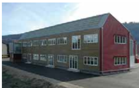
Façade long pan nord
