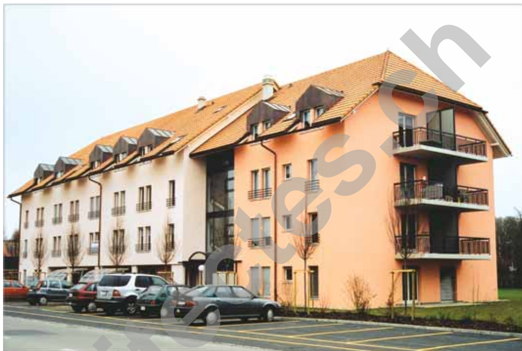
Accès au Nord, avec aménagement de places et chemin piétons
