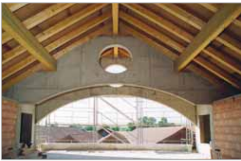
Combles en travaux...
