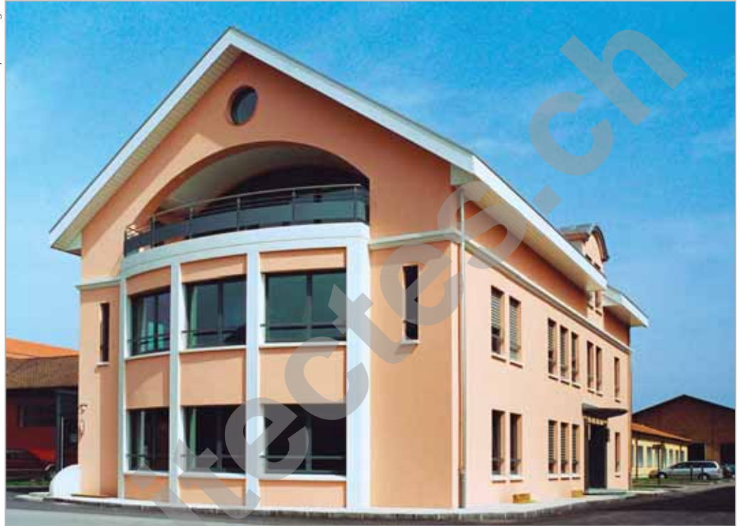
Bâtiment situé au centre du site principal de Corcelles
