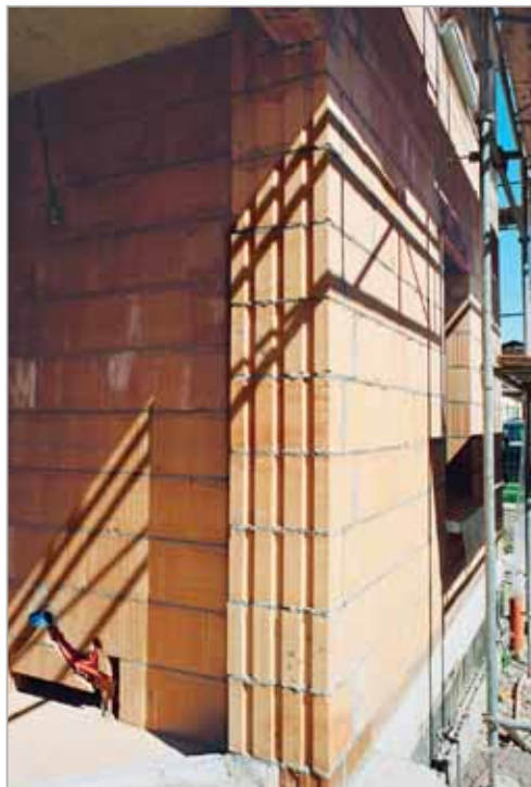
Détail de construction - Brique Ambiotherm
