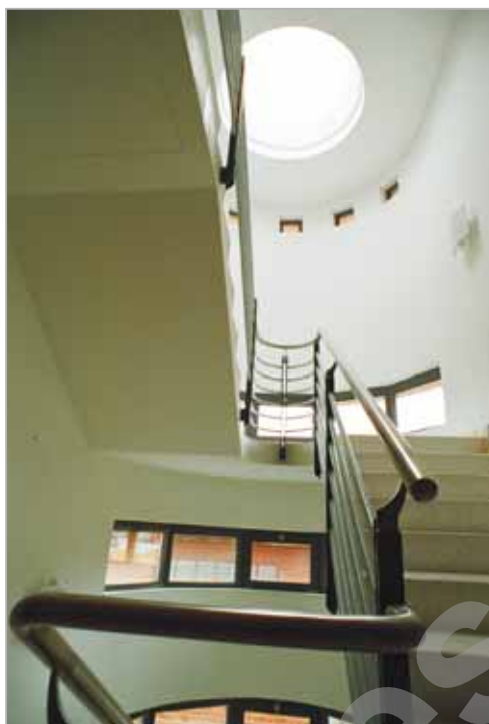
Eclairage zénithal dans les circulations
