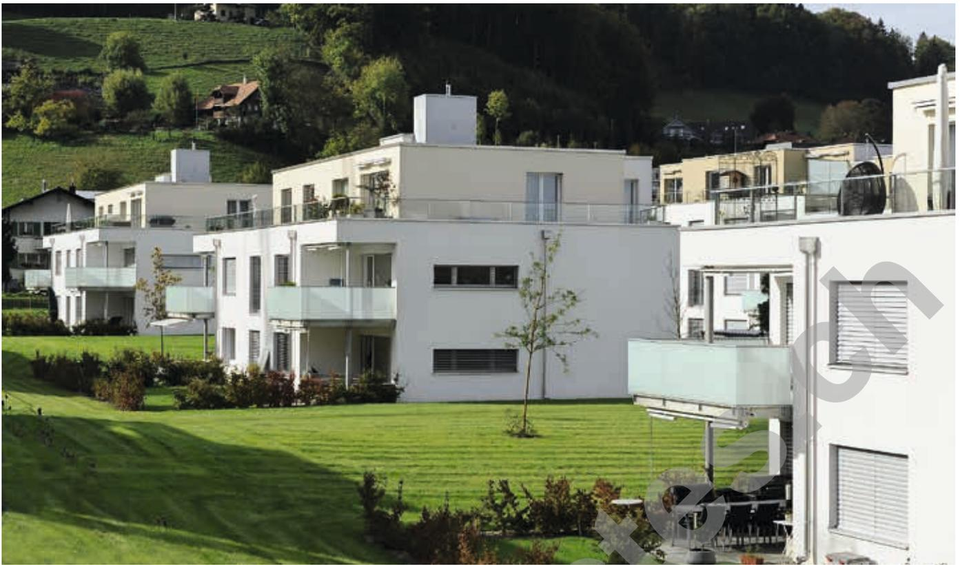
Mieter angepasst wurden. Die vierstöckigen Gebäude entsprechen einem traditionellen Massivbau und sind mit einer einfachen Aussenisolation versehen. Die Fenster bestehen aus zweifachen Isolierverglasungen. Die Flachdächer wurden mit Bitumen versiegelt und extensiv begrünt.
