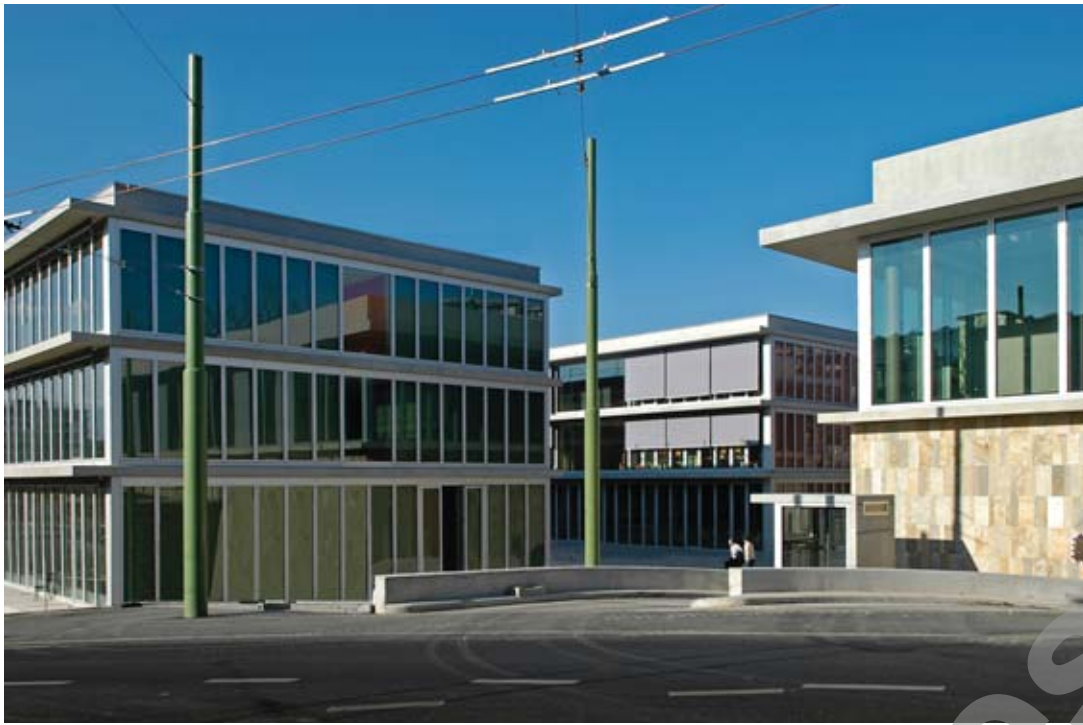
Vue sur les trois bâtiments
