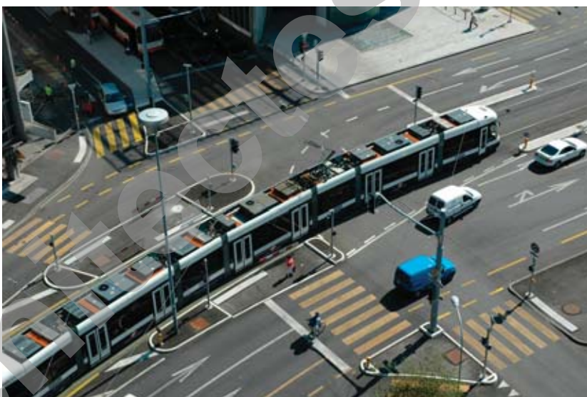
Passage d'une rame au carrefour de l'Etoile
