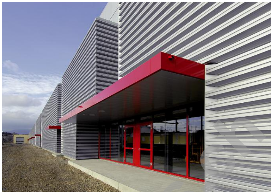
Nouvelle halle, façade sud
