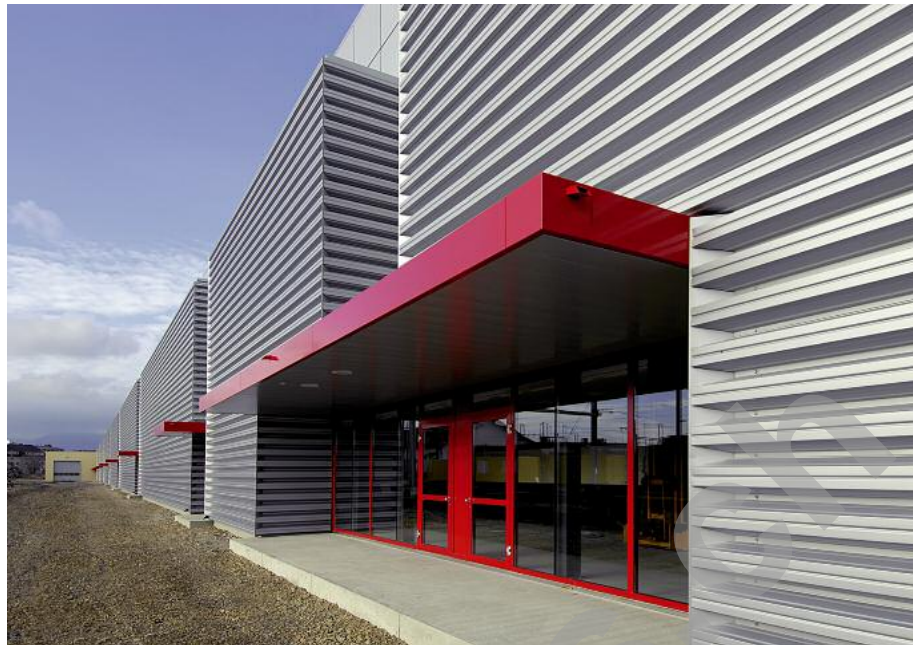
Nouvelle halle, façade sud
