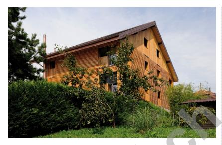
entre bâtiments existants. Une isolation incombustible a été intégrée en toiture et en façades. Les espaces ventilations entre étages et dans les angles du bâtiment ont été interrompus afin de rendre l'ouvrage conforme aux normes et prescriptions en vigueur.
