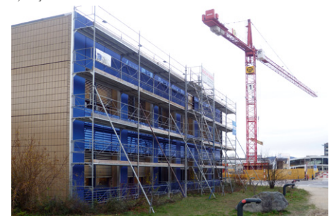
5) Façade Swissino en voie de finition
