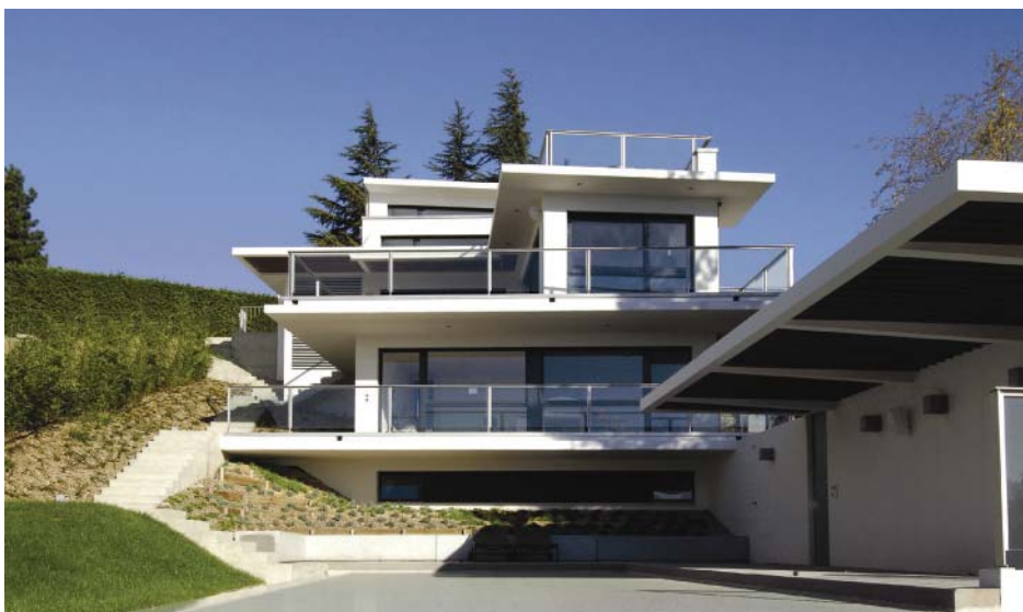
Vue sud avec piscine
