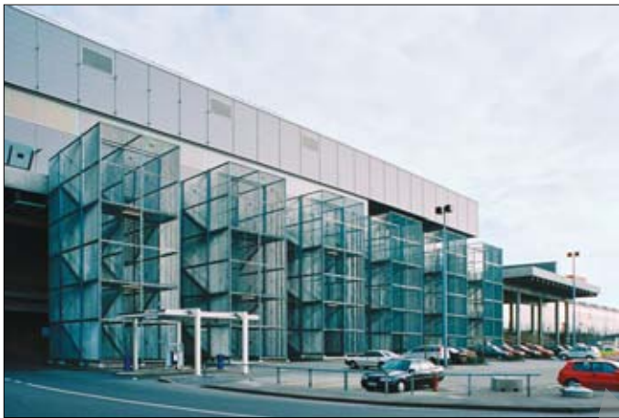
Escaliers de secours côté Aéroport
