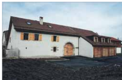
après la restauration
