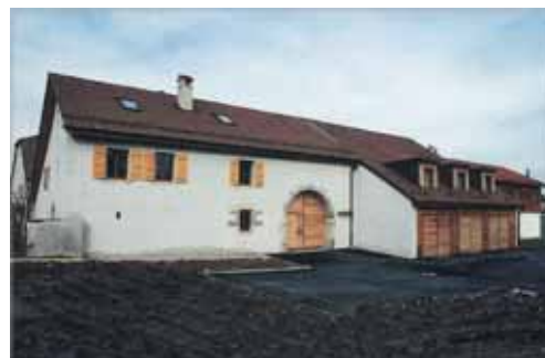
après la restauration
