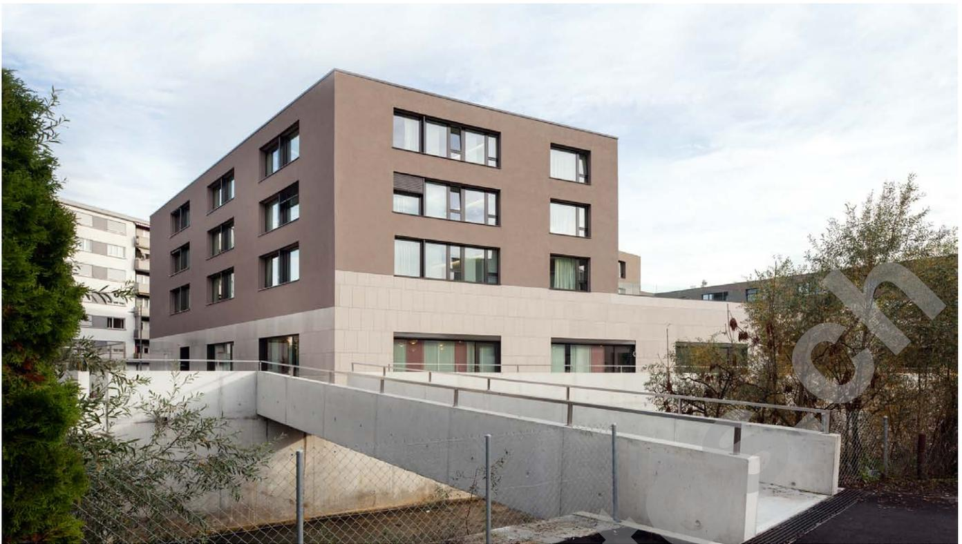
La structure porteuse est conçue pour être parallèle aux façades afin de libérer le positionnement des cloisons entre les appartements et les chambres de la résidence assurant une flexibilité d'aménagement à long terme.
