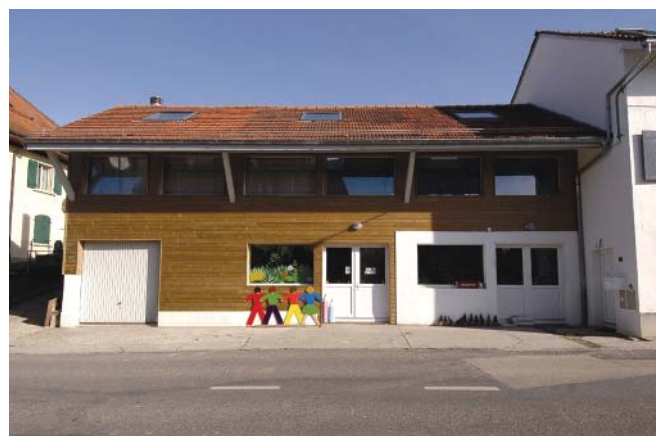
Vue côté rue après travaux
