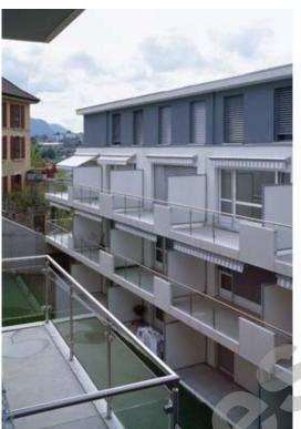
La réalisation, classique, fait appel au béton armé et à la maçonnerie de terre cuite en façade, sur laquelle une isolation périphérique, crépie, est appliquée.
