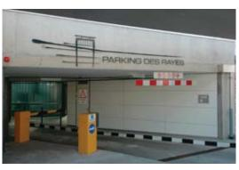
Quant à la face hors-sol dans laquelle s'ouvre l'accès véhicules, ses murs de béton sont garnis par un clayonnage en bois de cèdre, propre à adoucir l'effet visuel de cet élément, tout en favorisant la perception d'un élancement horizontal.
