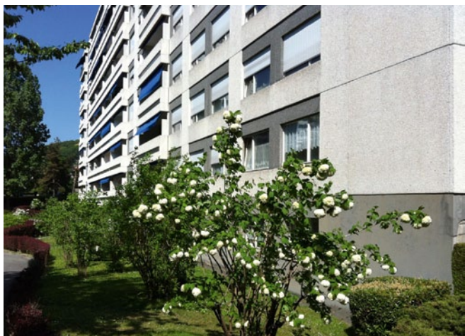
Façade avant travaux
