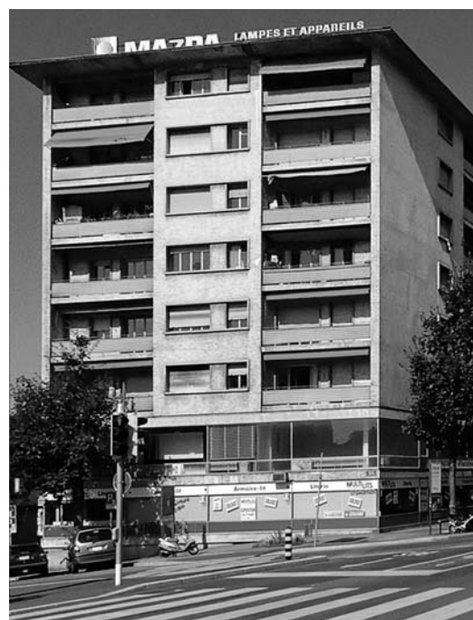
Façade Est, avant travaux
