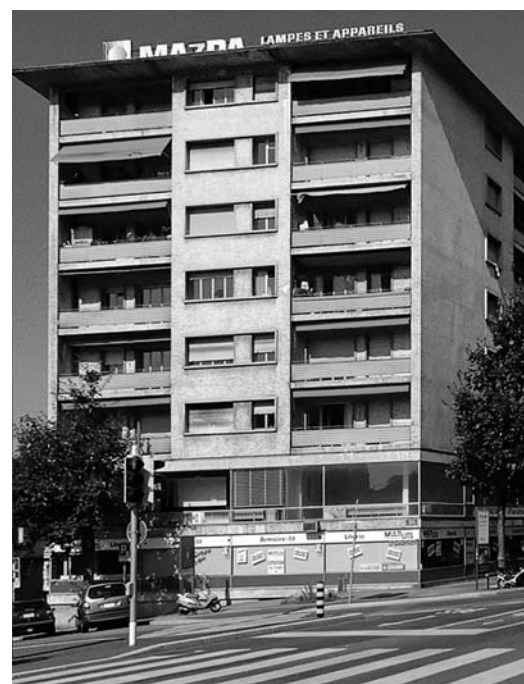
Façade Est, avant travaux
