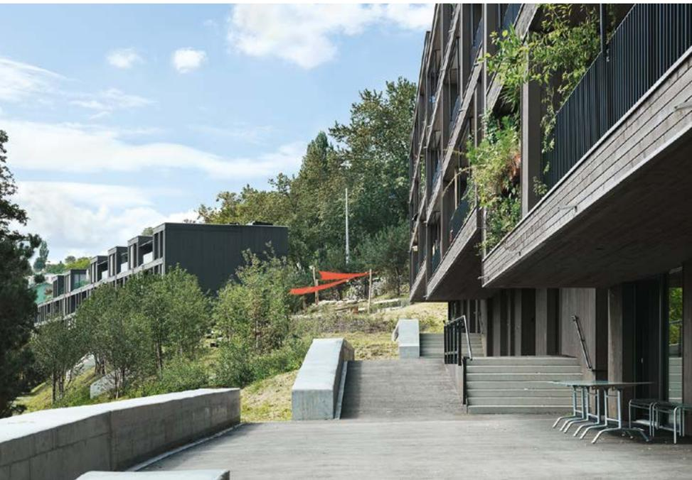
Bistro und ein Gemeinschaftsraum zur Verfügung. Beide Gebäude besitzen eine identische, dunkel gestrichene, sägerohle Holzfassade. Sie tritt als Geflecht mit vertikalen und horizontalen Elementen in Erscheinung und wirkt leicht. Die Erstellung der Überbauung in Holzbauweise mit einer inneren tragenden Betonstruktur gewährleistet bei einem kompakten Wandaufbau einen hochwertigen Wärmeschutz.
