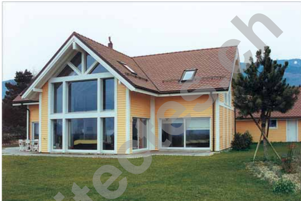
Grandes baies vitrées au Sud
