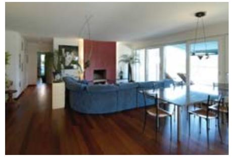
Les fenêtres et baies vitrées coulissantes sont en verres isolant et sécurisé, montés sur cadres en PVC. Les cloisons intérieures sont en plâtre sur ossature métallique. Un soin tout particulier a été porté sur le choix
