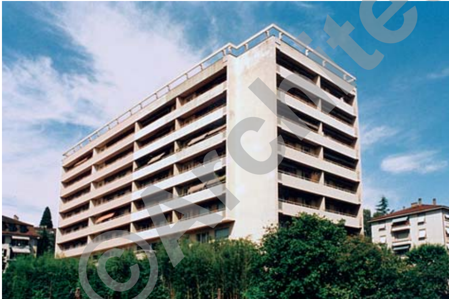
Vue avant travaux
