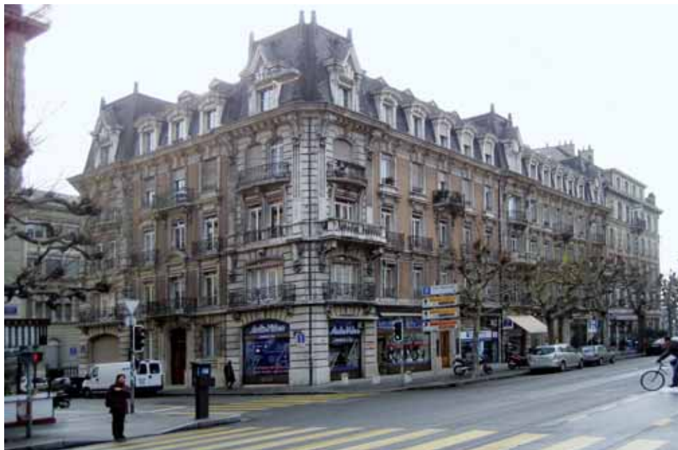
Bâtiment avant transformation
