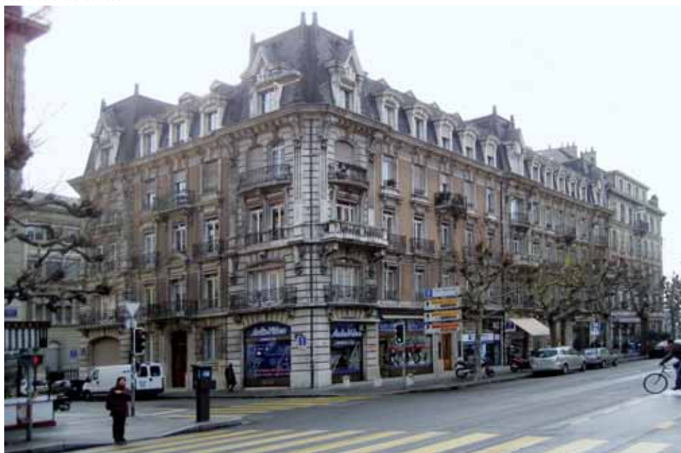
Bâtiment avant transformation
