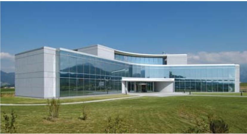
intégrant le chauffage ou le refroidissement, en complément de la ventilation, par le plafond métallique actif. La façade "double peau" en verre contribue également au système, l'air ambiant est aspiré dans la partie supérieure de l'espace intermédiaire, il est canalisé entre les 2 vitrages et neutralise ainsi les effets du chaud ou du froid provenant de l'extérieur.
