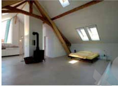
La toiture a entièrement été refaite et isolée, la charpente en bois consolidée et adaptée. Dix nouveaux velux en toiture ainsi qu'une grande ouverture triangulaire en façade amènent un maximum de lumière naturelle.
