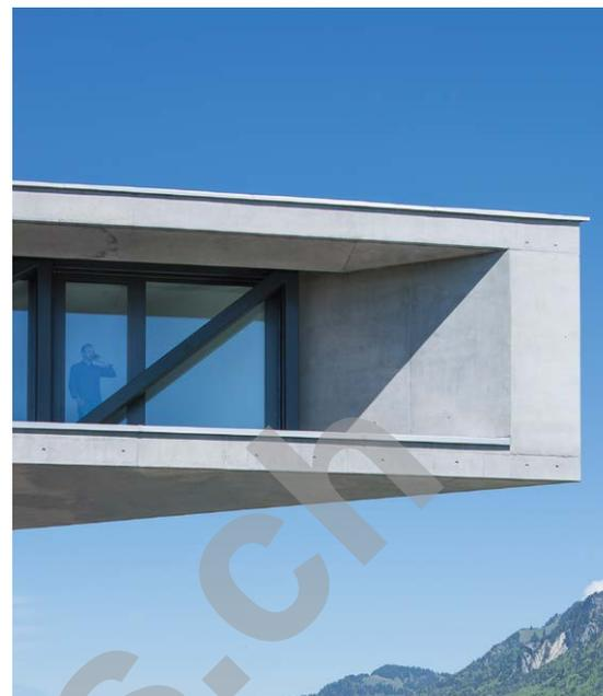
L'isolation de l'ouvrage a été réalisée depuis l'intérieur afin de laisser le béton apparent en façade. Cette manière de faire a nécessité une gestion pointue des ponts thermiques.
