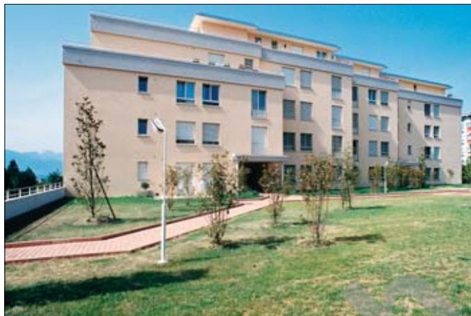
L'enveloppe du bâtiment est composée de façades à isolation périphérique avec enduit crépi, et d'une toiture plate, en béton armé, avec complexe isolant-étanche multicouche.
