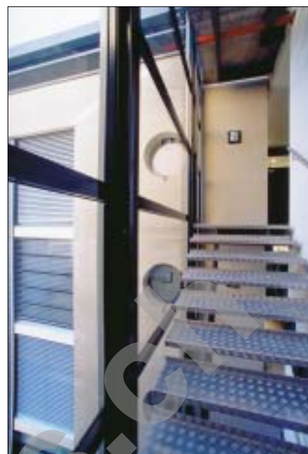
Escalier d'accès aux étages Terrassière no 23
