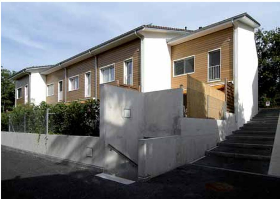
Chaque unité est autonome pour son chauffage et sa production d'eau chaude. Les panneaux de façades ventilés en bois et la charpente en caissons isolés des toitures ont été préfabriqués en atelier.
