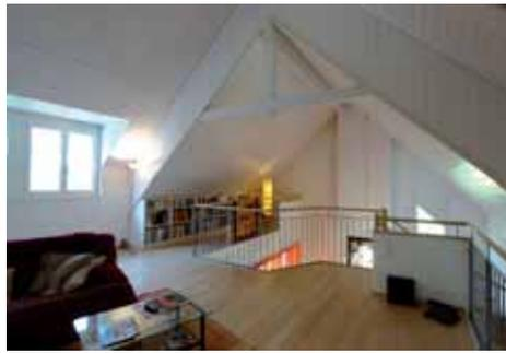
Les galandages sont également en briques de terre cuite, revêtues de plâtre. La charpente est en épicea et la couverture en tuiles plates. La source énergétique pour le chauffage est le gaz.
