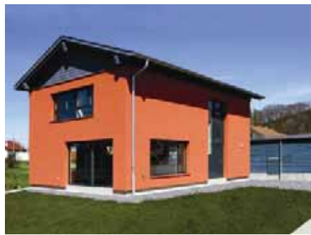
Villa 4 - Vue générale sud et ouest
